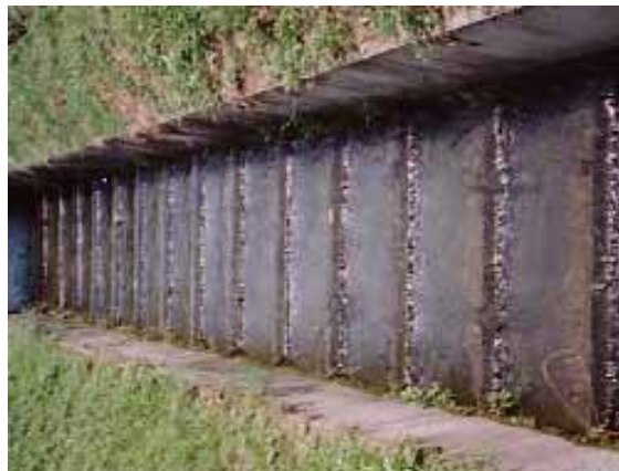
3面張り水路、床に碎石を敷いて洗掘防止と地下水浸透を促している。
