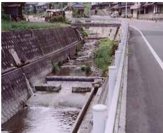
ブロック積護岸で固められ、わずかに草が生えるがほとんどは砂礫のみである。
