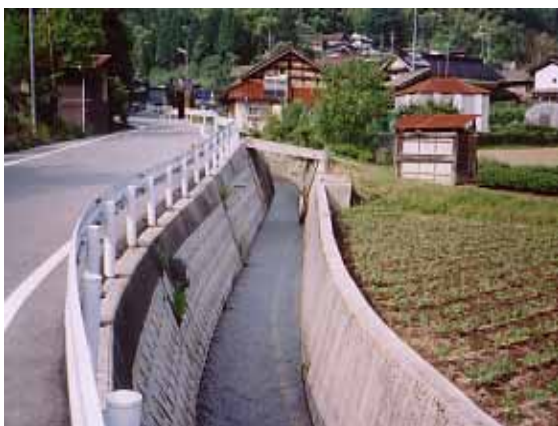
3面張り水路、降雨は一気に下流へ流れる。
