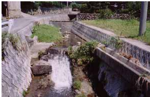
護岸で固められ水草も少なく、虫や魚の住みにくい川である。
