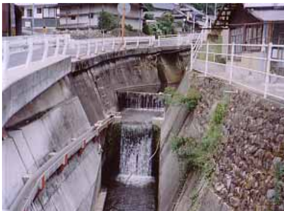
3面張+段差工で固められた水路である。
