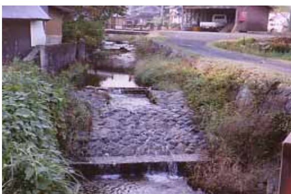
石積頭首工+床止め工。魚と自然に優しい構造である。
