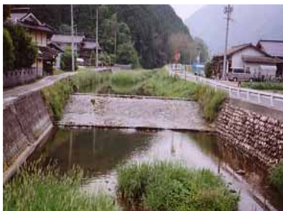
両側はブロック護岸で河床はヨシなどが生え小魚が泳いでいるのみ。
