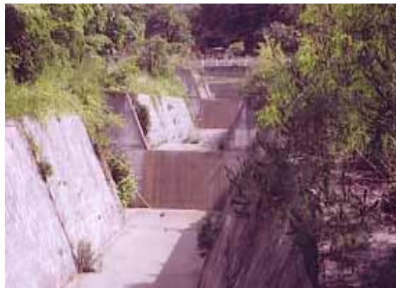
3面張+段差工で固められ、全くの人工水路である。
