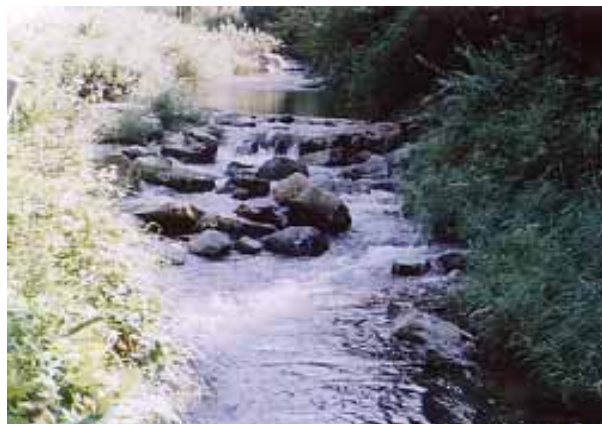
自然石による床止め工。自然状態に近く見ていて心安らぎ、魚にも優しい。
