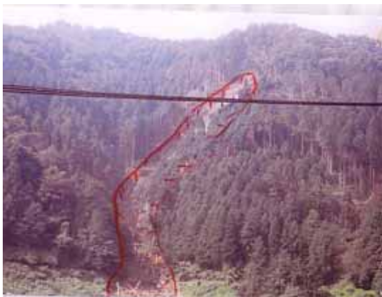
植林地の風倒木が雨で斜面崩壊を起こし倒木が斜面下まで押し流されている。
