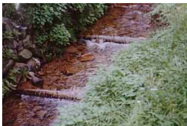
丸太による床止め工。植林木を有効活用でき、自然に優しく経済的である。
