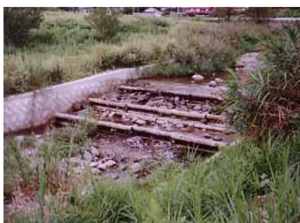
丸太と石による床止め工。自然に優しく中小河川では十分機能している。
