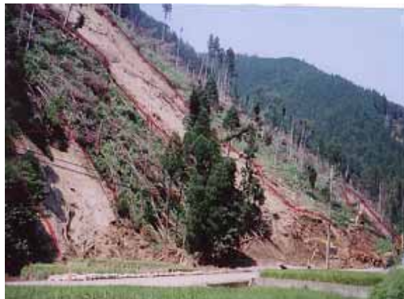
植林地の倒木と斜面崩壊。倒木被害も激しいが表層崩壊も著しい。
