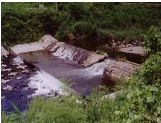
昔の石積頭首工である。勾配が緩く魚と川にやさしい構造である。
