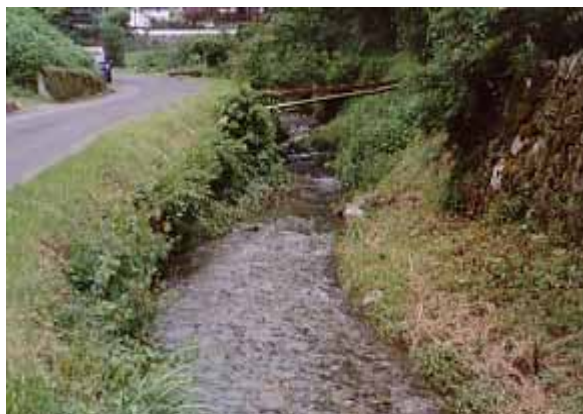
斜面と道路で挟まれた小川。岸に草が生えせせらぎを呈している。
