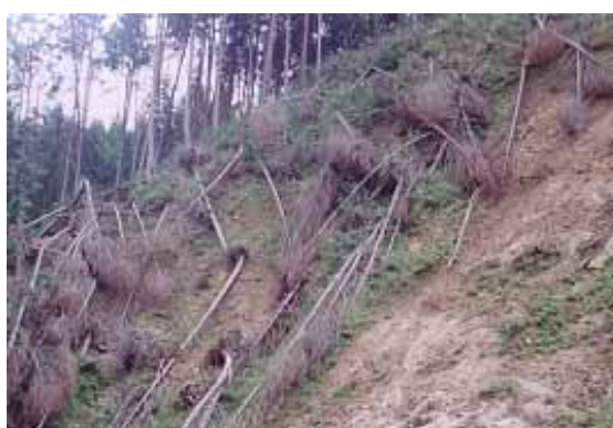
風倒木地は斜面崩壊により表土や土壌が失われ、風化岩が現れている。
