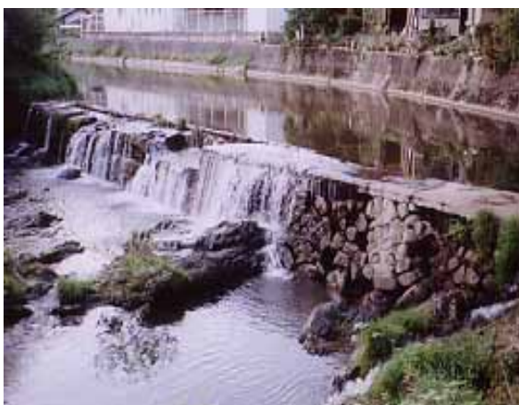
昔の石積頭首工である。石が崩れかけているが魚の住処は多い。
